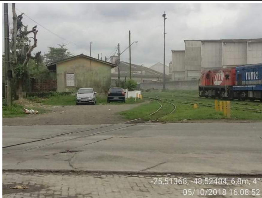
Figura 52. Imagem da bifurcação na passagem de nível, ilustrando a condição do pavimento e ausência de sinalização viária (perspectiva olhando a partir da portaria de saída da BRFétil – para norte).
