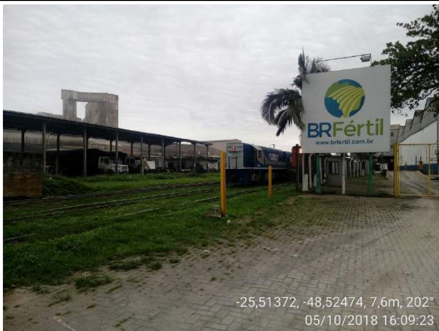
Figura 54. Passagem de nível (perspectiva olhando para a portaria de saída da BRFétil – para Sul) Imagem mostra o espaço suficiente existente entre a linha férrea e a saída do empreendimento.
