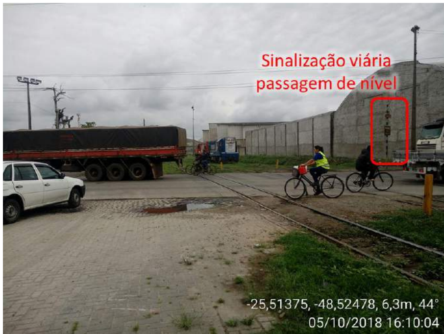
Figura 53. Passagem de nível (perspectiva olhando à direita da portaria de saída da BRFétil – para Leste/Sudeste) Imagem mostra a falta de sinalização viária horizontal e deficiência na sinalização vertical.
