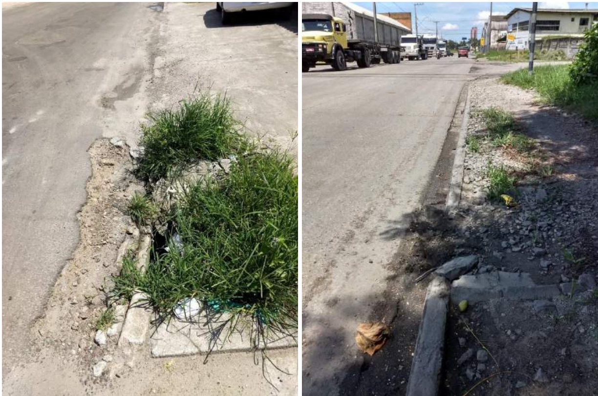
Figura 45: Bocas de lobo obstruídas na Rua José Cadilhe e na Av. Coronel Santa Rita.
