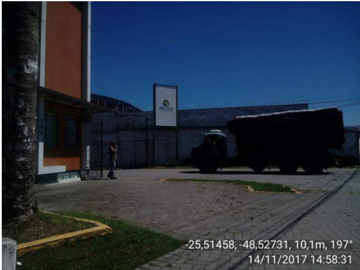
Figura 5: Portaria de entrada do empreendimento, na R. José Cadilhe.
