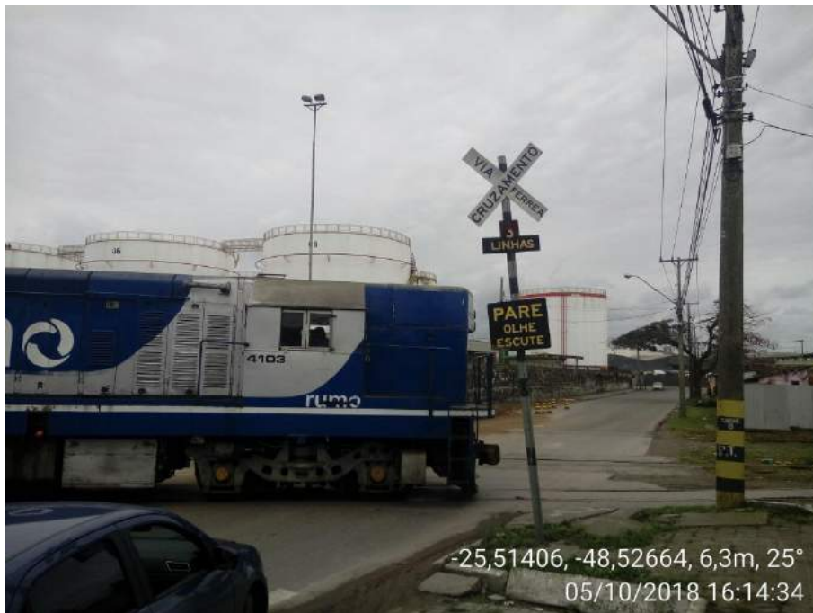
Figura 50. Sinalização viária junto à passagem de nível.
