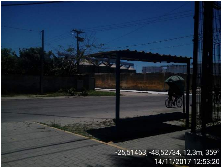
Figura 81: Ponto de ônibus em frente à portaria da BRFértil, e ausência de faixa de pedestres.
